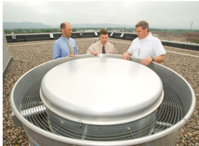
Exhaust Fan Motors
